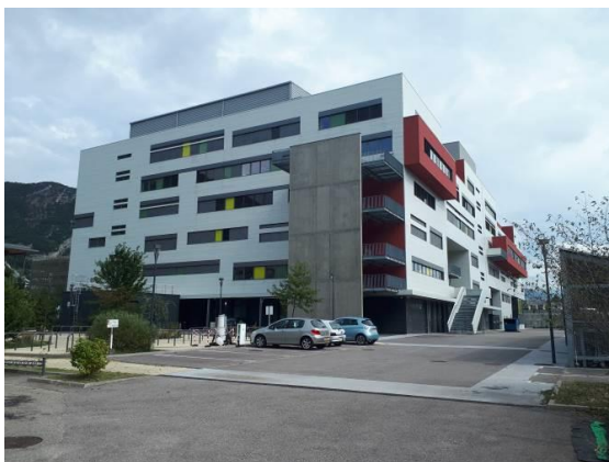
Figure 2 : façade nord-ouest du bâtiment GreEn-ER
